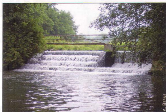
Figure 1. Le barrage du moulin à papier est le dernier obstacle sur l'axe Touques-Calonne. Cet ouvrage ne bénéficie d'aucun dispositif de franchissement, empêchant la colonisation de la haute-Calonne par la truite de mer. Le barrage est totalement infranchissable, trop haut malgré la puissance de saut de certains salmonidés
